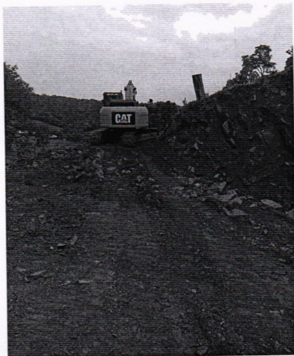
Figura 1. Abertura de vias de acesso mediante utilização de escavadeira hidráulica
