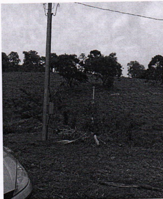
Figura 2. Instalação de poste (COPEL) para fornecimento de energia elétrica ao paiol
